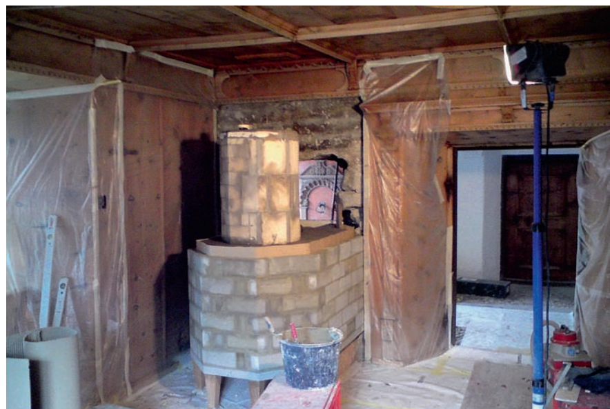
Aufbau des Turmofens im Sprecherhaus in Luzern
